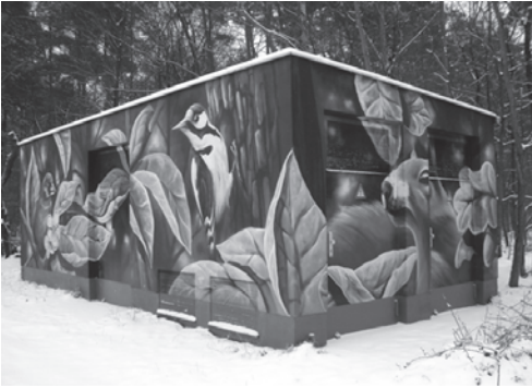
Trafohaus in der Genovevstraße
